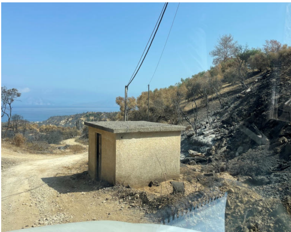
(Φωτό 3, γεώτρηση Δρεσθαινών)
