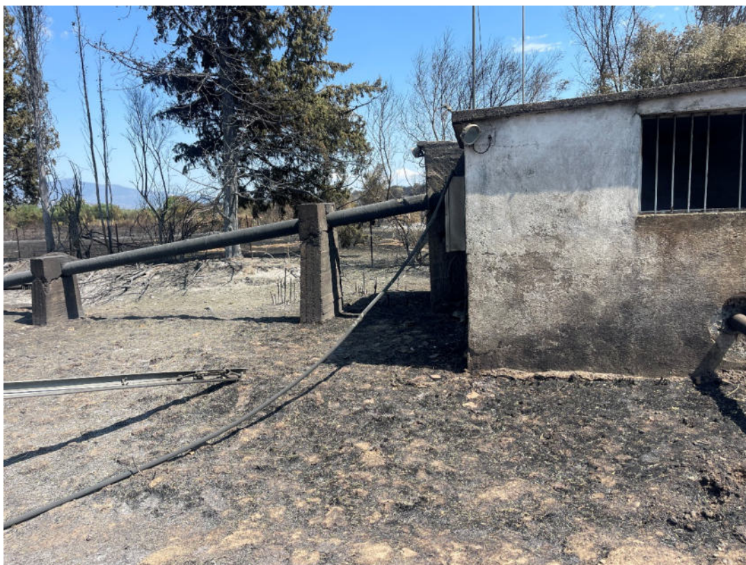
(Φωτό 5, η γεώτρηση της Καμενίτσας)
